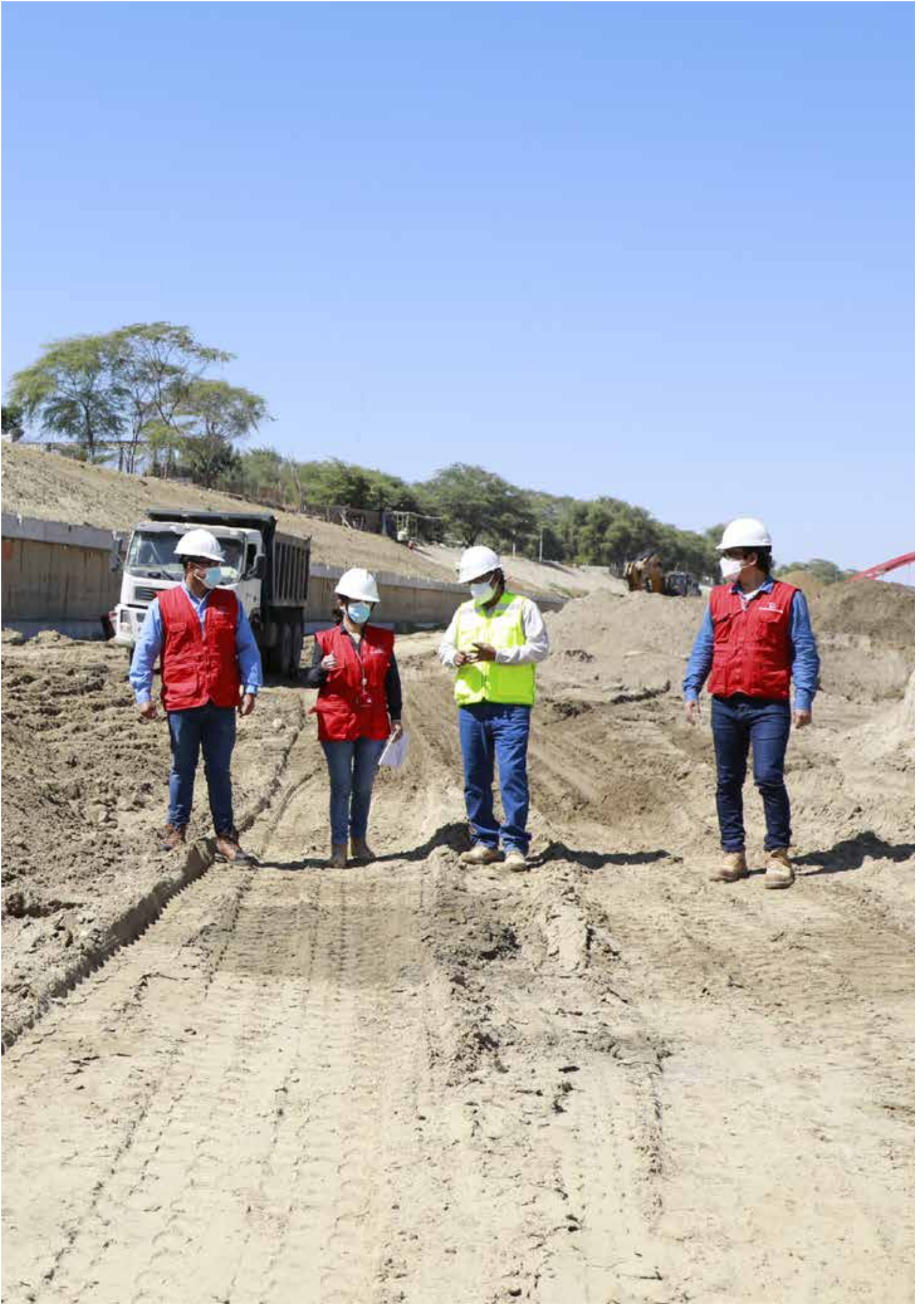
Audidores supervisan obra de defensas ribereñas en el tramo II del río Piura.
